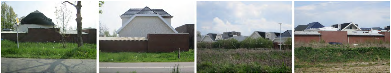
fig05 locatie O (IJsselcentraleweg) en locatie E (Bastionstraat) bestaande situaties met wagens die ver boven bergingen torenen
