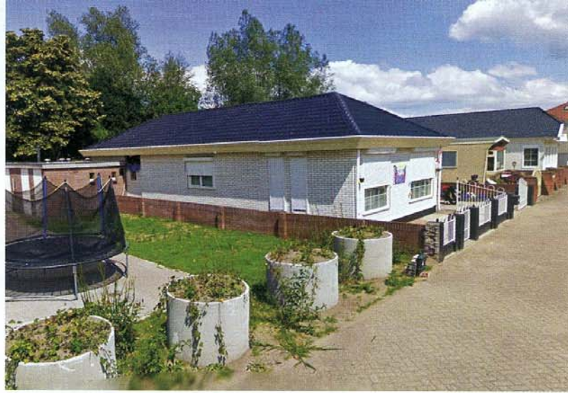
Betonbuizen blokkeren lege standplaats
