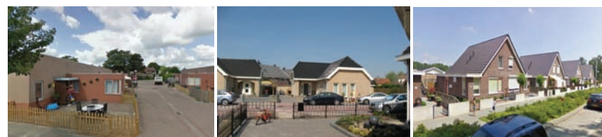
Woningbouw in Zwolle, Raalte en Enschede
